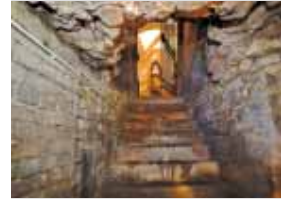
Abstieg zu den Domfundamenten (Seiten 80-87)
